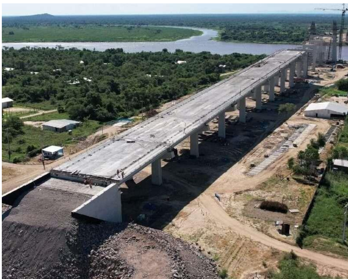
Figura 6 - Ponte Internacional ligando Porto Murtinho no Brasil a Carmelo Peralta no Paraguai
